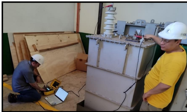
Ilustración 59: Alumnos Realizando Pruebas en Transformador con TTR/DTR 8510.
