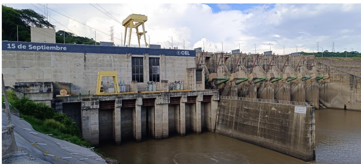
Ilustración 91: fachada de la Central Hidroeléctrica 15 de Septiembre.
