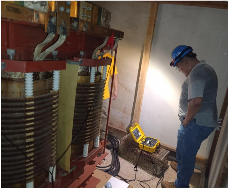
Ilustración 105: Estudiante Realizando Pruebas de Continuidad a Bobinado del Transformador.
