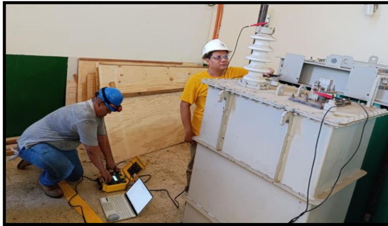
Ilustración 58: Alumnos Realizando Pruebas en Transformador con TTR/DTR 8510.
