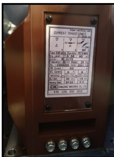
Ilustración 68: Placa de Datos de un Transformador TC.
