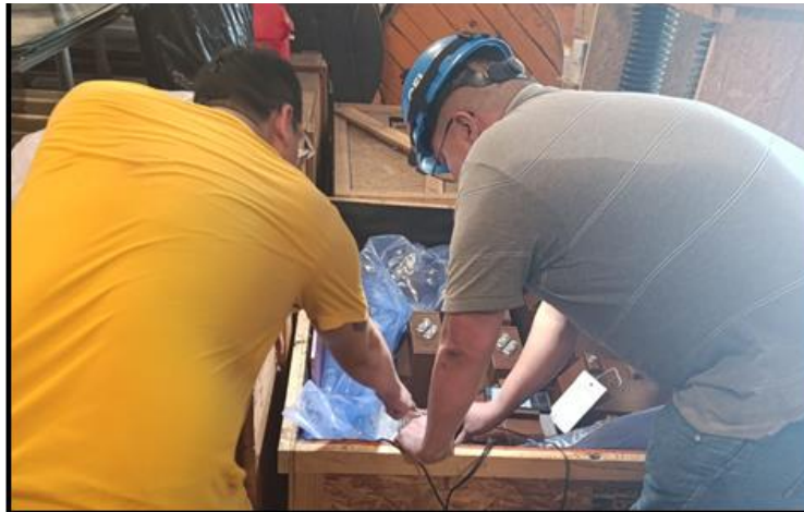
Ilustración 70: Alumnos Realizando Pruebas en Transformador con TTR/DTR 8510.
