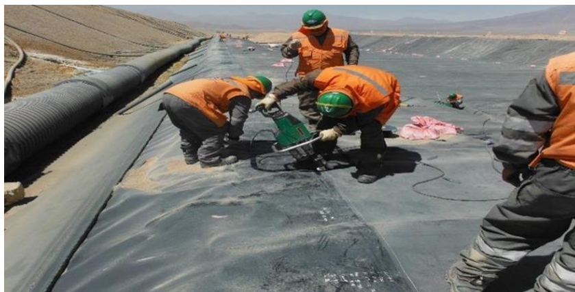
Ilustración 38: Colocación de geomembrana
