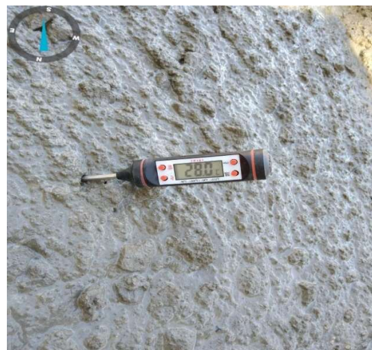
Imagen 54: Temperatura del concreto.
