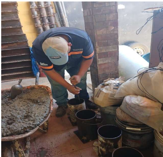
Imagen 46: Llenando cilindros con concreto.
