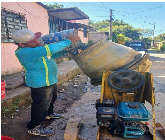
Imagen 44: Elaboración de mezcla de concreto.
