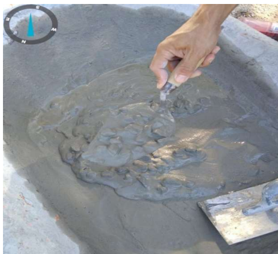
Imagen 55: Mezcla de Concreto con arena de mar.
