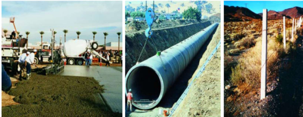
Imagen 6: Concreto con Cemento de alta Resistencia a los sulfatos.
