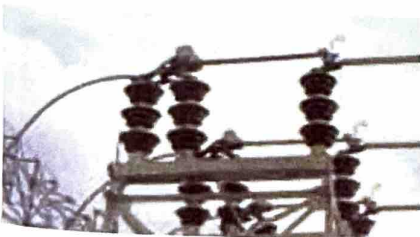
Imagen 4. 3 – Inspección de conectores en alta tensión desde una distancia segura: FLIR. Guía de termografía para mantenimiento predictivo.
