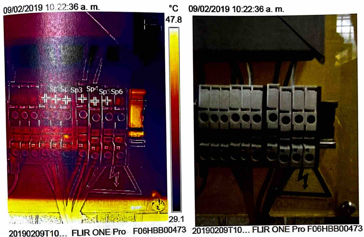
Imagen 6. 46– Temperatura de las borneras ajustadas correctamente. Fuente: Informe FLIR Tools
