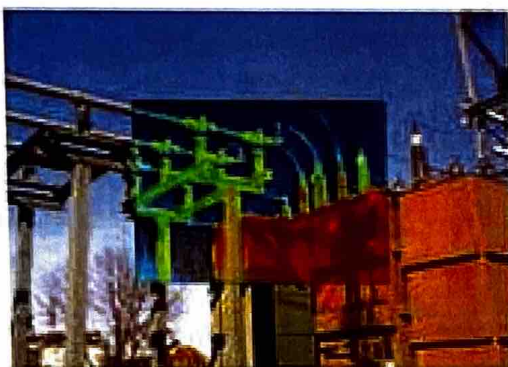
Imagen 4. 1—Termografía de un Transformador de Potencia. Fuente: Interempresas.net, agosto 2018.
