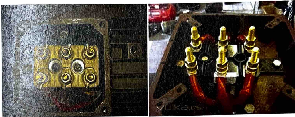
Imagen 2. 17– Caja de conexiones de un motor eléctrico. Fuente: Imágenes Google, agosto 2018.
