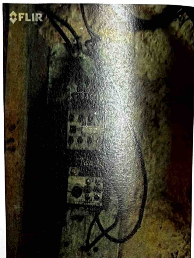
Imagen 4. 7– Puntos calientes en contactor monofásico 240 v. Fuente: Propia
