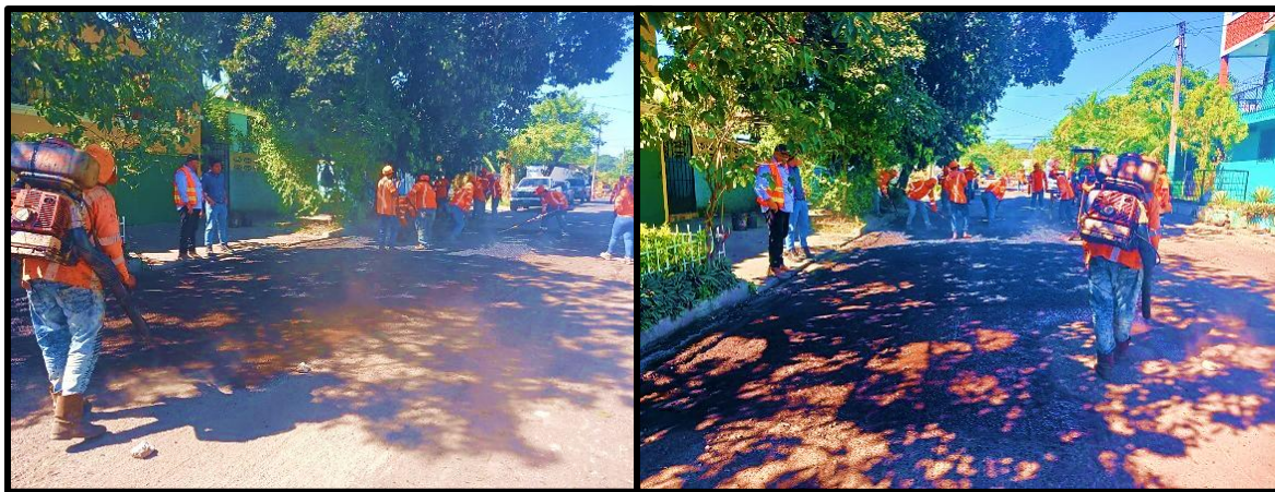
Fotografía 22. Riego de liga para bacheo.
