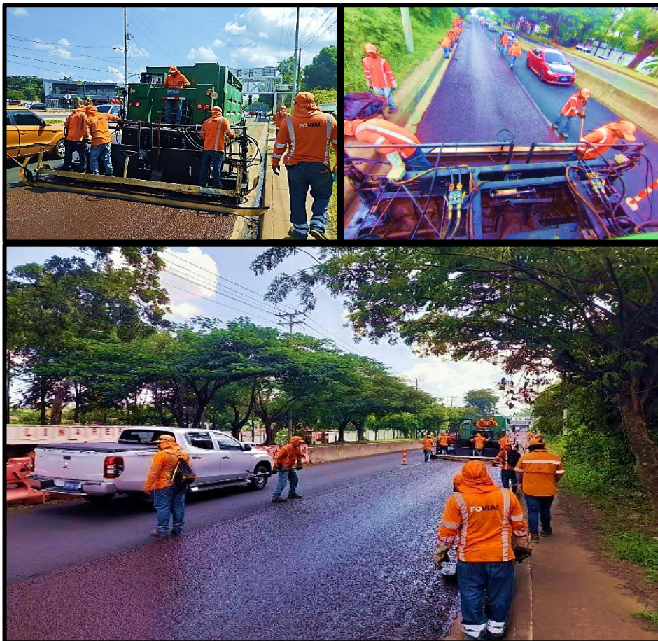
Fotografía 24. Colocación de micropavimento.
