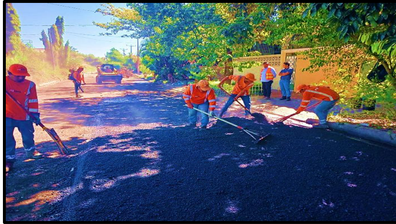
Fotografía 23. Colocación de Mezcla Asfáltica en bacheo.
