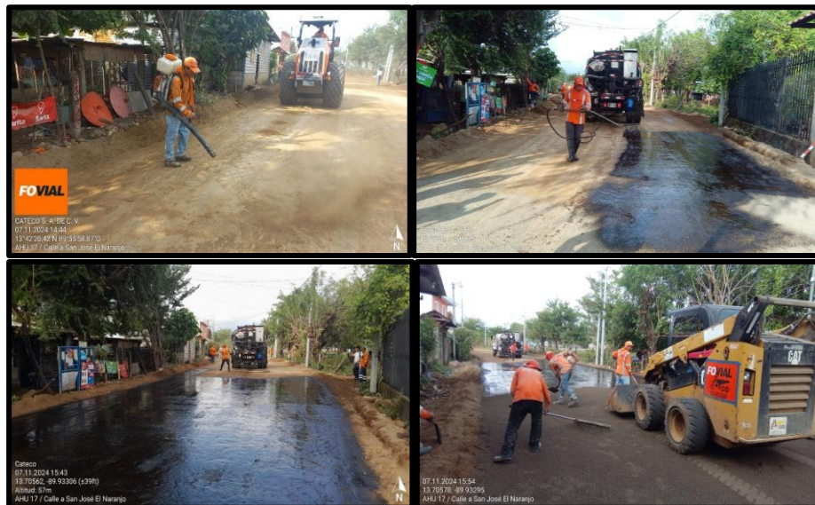
Fotografía 23 Riego de Imprimación en proyecto periódico, FOVIAL.
