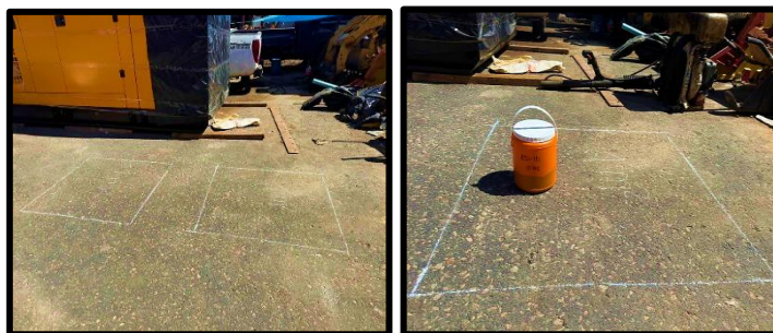
Fotografía 19. Riego de Fog Seal (Sello de Niebla), con emulsión CSS-1H
