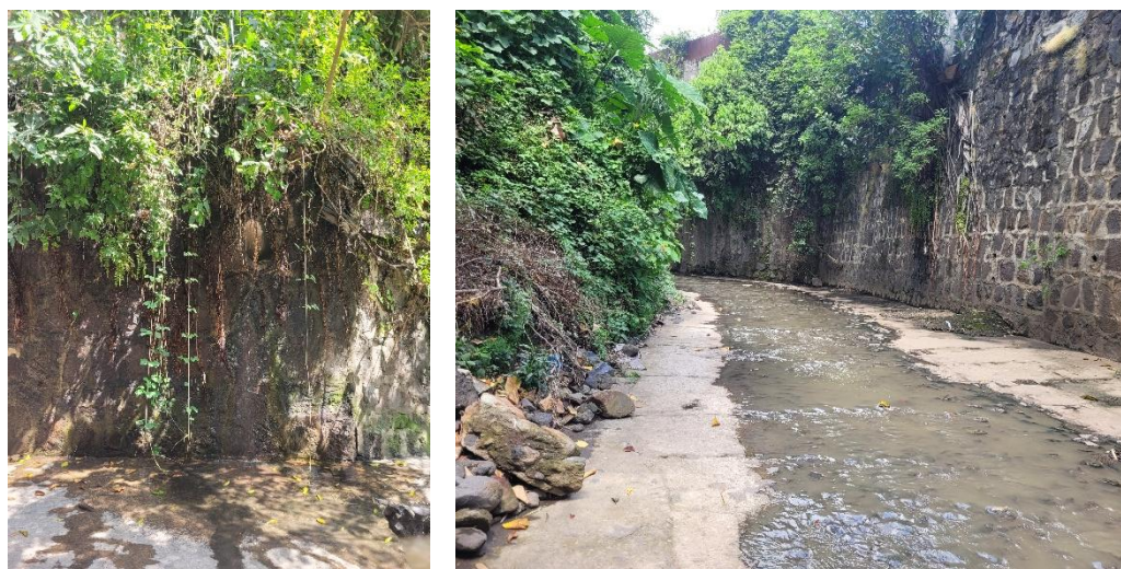
Figura 3.6 Muros laterales aguas arriba del ingreso a la Bóveda hidráulica bajo 79 Av. Sur en Quebrada La Mascota. Fuente: Estefany Cárcamo 2024.
