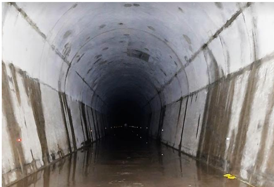
Figura 2.6 Fotografía de bóveda de sección de herradura en Presa El Chaparral, San Luis de La Reina, San Miguel. Fuente: Estefany Cárcamo 2022.
