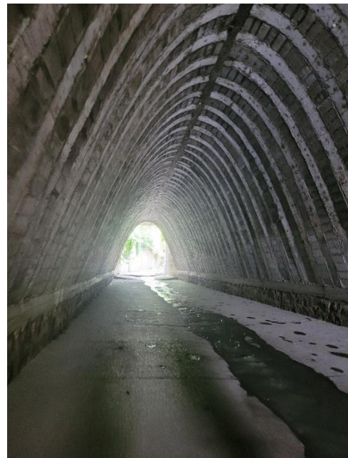
4- Interior de bóveda parabólica 79 Av. Sur.
