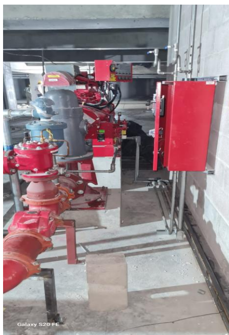
Ilustración 7 Instalación de motor y bomba contra incendios
