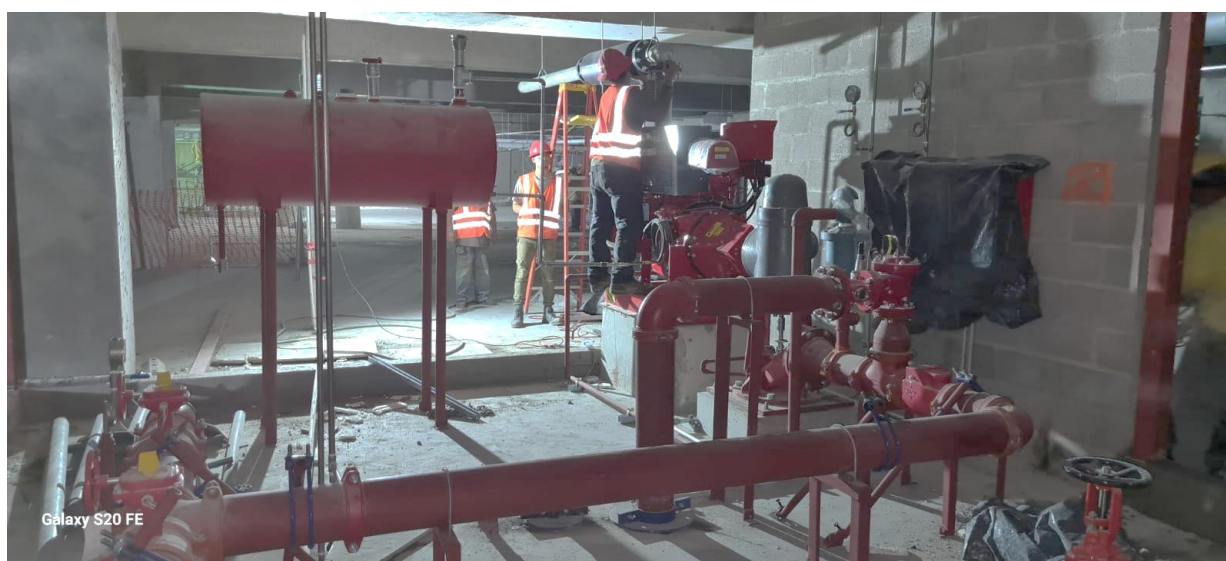
Ilustración 8 Trabajos en cuarto de bomba contra incendios
