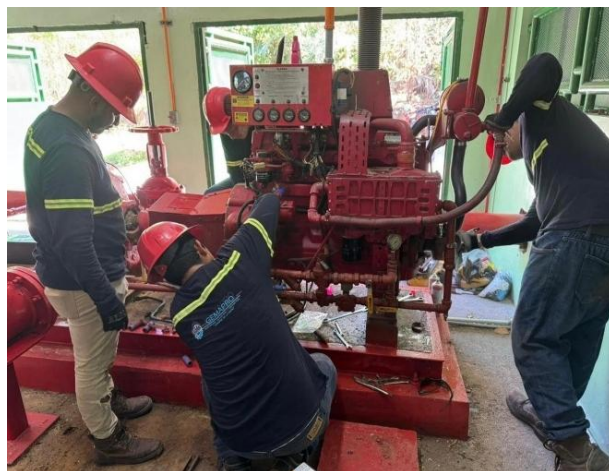
Ilustración 6 Mantenimiento a motor de sistema contra incendios
