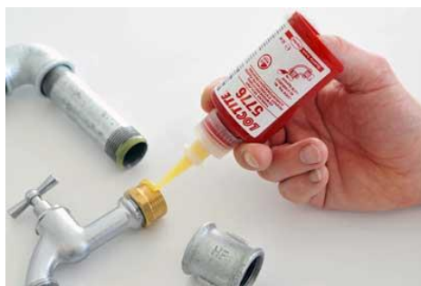
Fig. 30 Sellado de roscas de tubería
