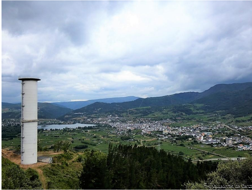
Imagen 19: Sistema con chimenea de equilibrio
