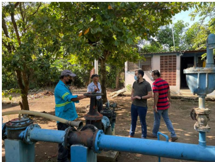
Imagen 1: Inspección de campo de tuberías de equipo de bombeo
