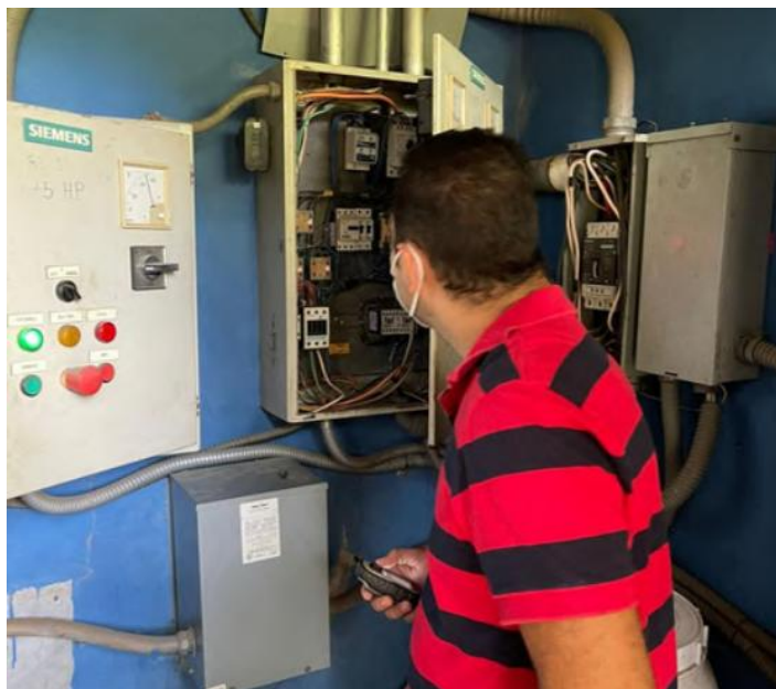
Imagen 2: Revisión de tablero eléctrico para equipo de bombeo
