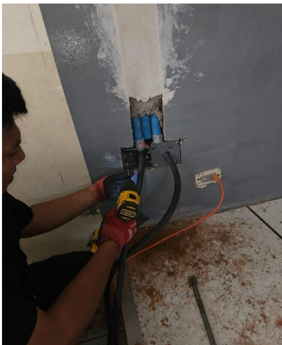
Figura 76. Instalación de tapadera para la salida del conductor eléctrico.
