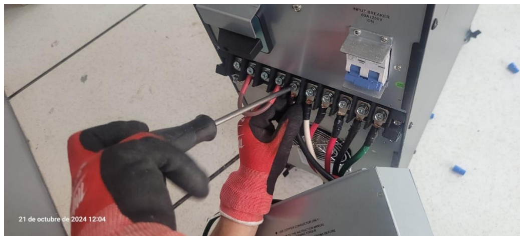
Figura 93. Conexión del UPS.
