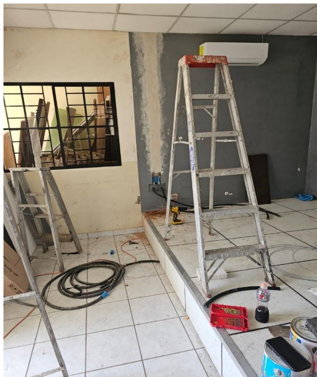
Figura 78. Reparación de pared por la instalación del conductor.
