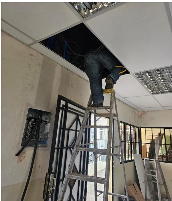
Figura 75. Instalación del cable para alimentación del UPS.
