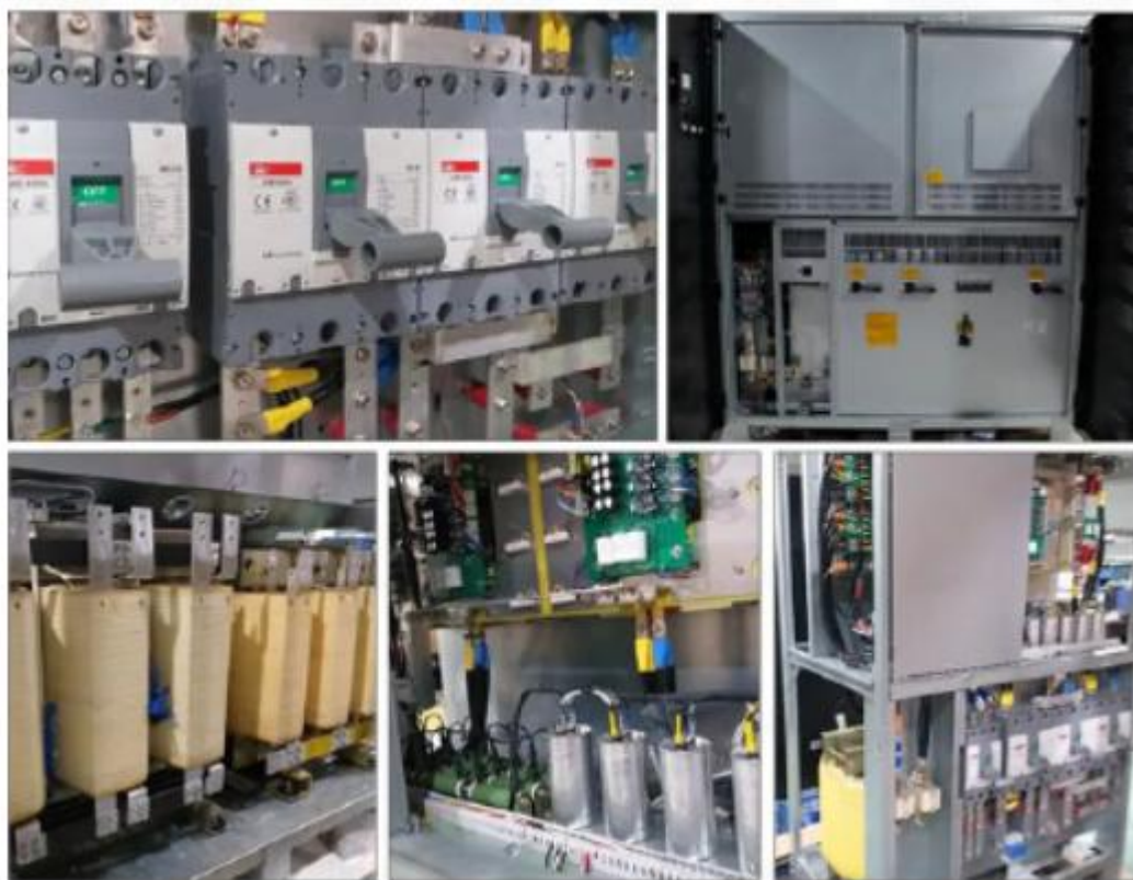
Figura 28. Estructura interna de un UPS trifásico. 44
