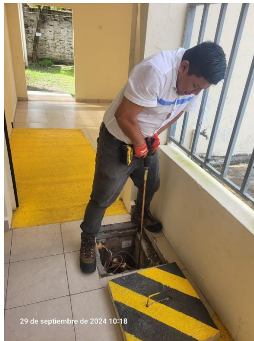
Figura 82. Instalación de barra de polarizado.
