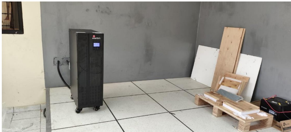
Figura 86. UPS instalado.
