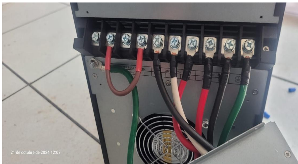
Figura 89. Conexión de salida y entrada del UPS.
