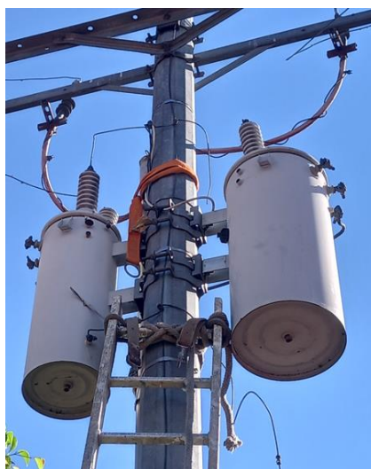
Figura 52. Amarre de escalera, instalación de punto de anclaje a nivel de poste y cuerda de vida del arnés. 88
