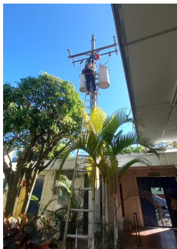
Figura 51. Amarre de escalera y posicionamiento de cinturón y bandola para trabajo en altura para realizar configuraciones de inyección de tensión 87 .
