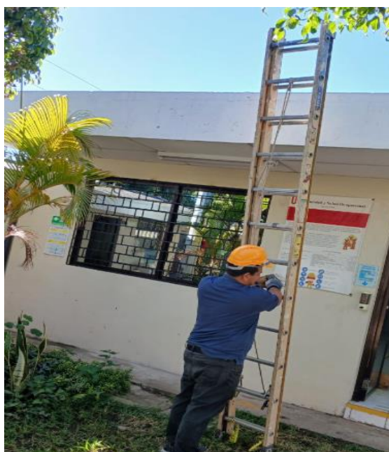
Figura 46. Manejo y uso correcto de escaleras con apoyo y asistencia de integrantes de equipo. 83
