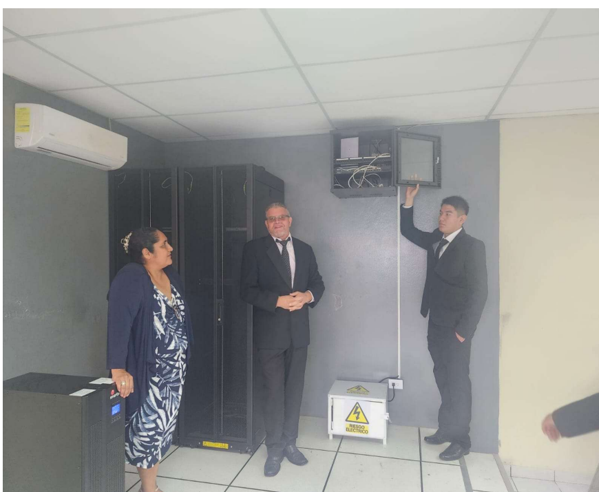
Imagen 63 Visita al Gabinete de equipos telecomunicaciones por parte del jurado
