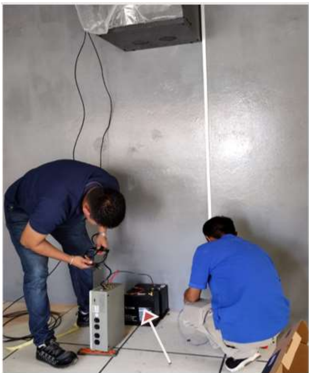
Imagen 53 Instalación de circuito eléctrico y respaldo
