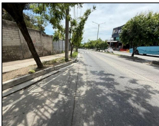
Ilustración 37. Punto de descarga 2 superficial a caja de aguas lluvias
