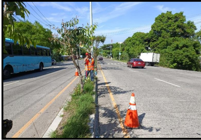
Ilustración 24. Levantamiento de arriates centrales y pozos existentes de A.LL.
