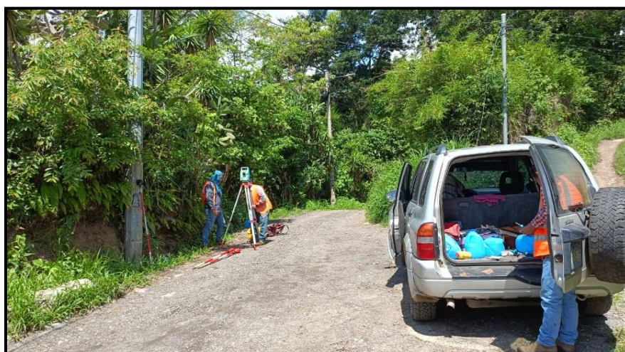
Ilustración 16, Colocación de PLG 1 - inicio de levantamiento
