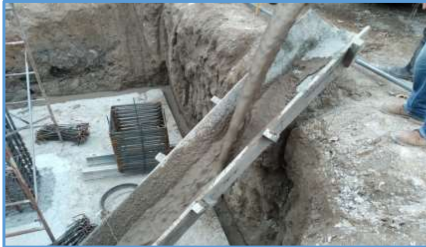
Ilustración 6: Relleno Fluido colocado como sustituto de compactación tradicional.
