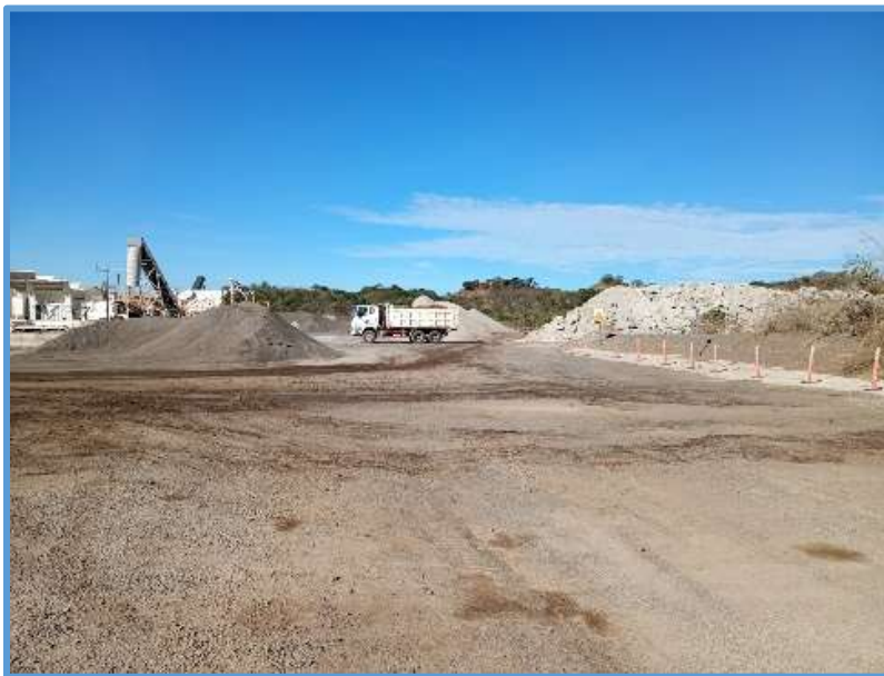
Ilustración 17: Interior de planta de agregados, donde se aprecia material fino manufacturado.
