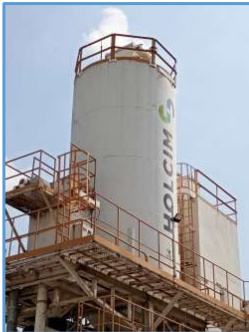
Ilustración 20: Silos de almacenamiento del Cemento.
