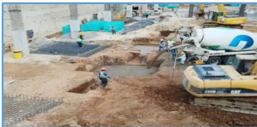
Ilustración 7: Relleno Fluido colocado para soporte en fundación aislada.
