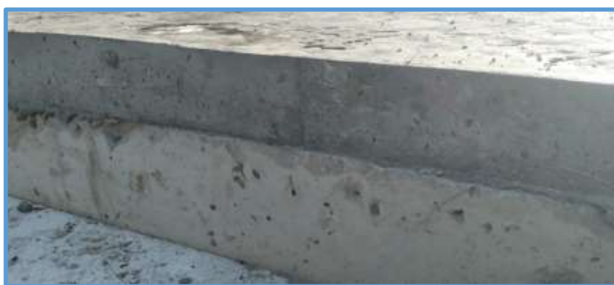
Ilustración 8: Relleno Fluido usado para soporte pavimento.
