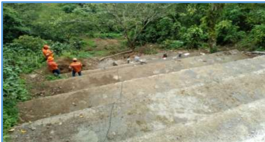
Ilustración 11: Relleno Fluido colocado en capas.
