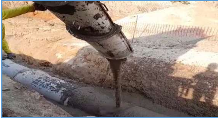
Ilustración 9: Relleno Fluido usado como recubrimiento de protección de tuberías.
