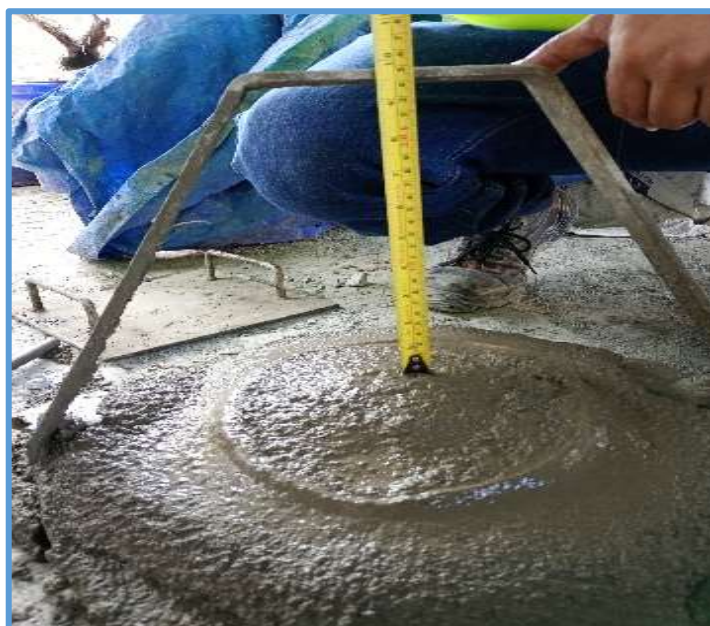
Ilustración 39: Ensayo de Revenimiento del material procesado.
