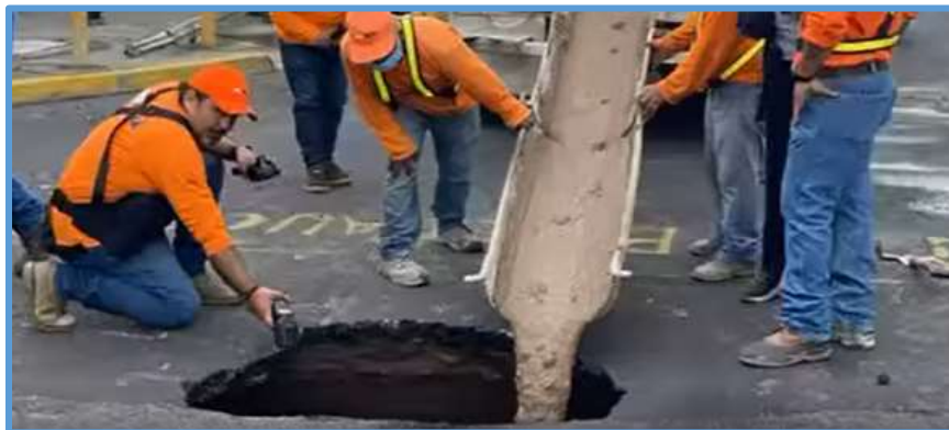
Ilustración 10: Relleno Fluido usado en rellenos bajo la superficie.
