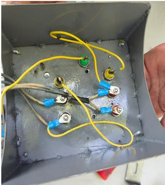
Instalación de conectores banana del motor a la base de conexiones construida.
