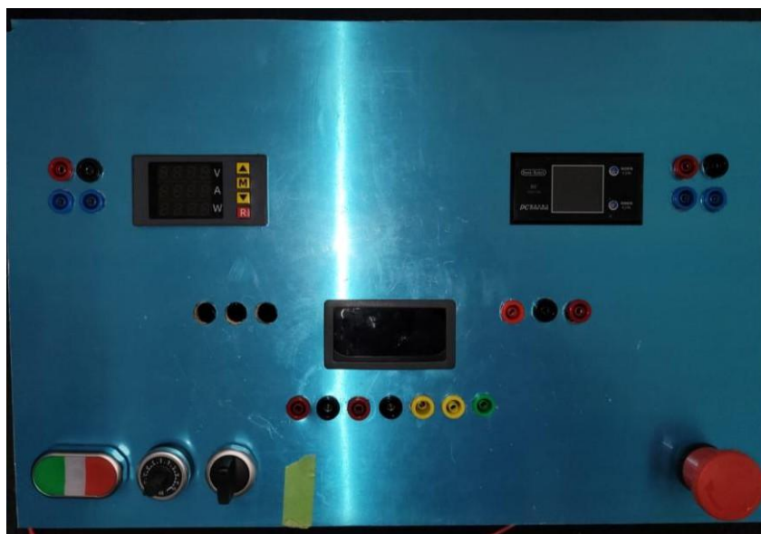
Instalación de dispositivos electrónicos y dispositivos de control vista opuesta.
