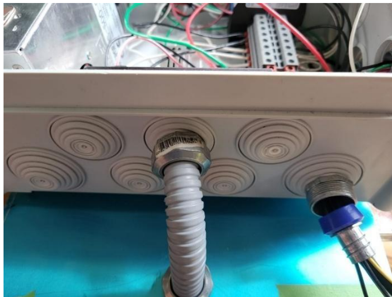
Instalación de coraza LT desde el panel de control a la caja plexo.
