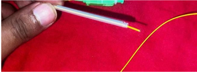
Figura 200. colocación de termoencogible en cable de fibra
