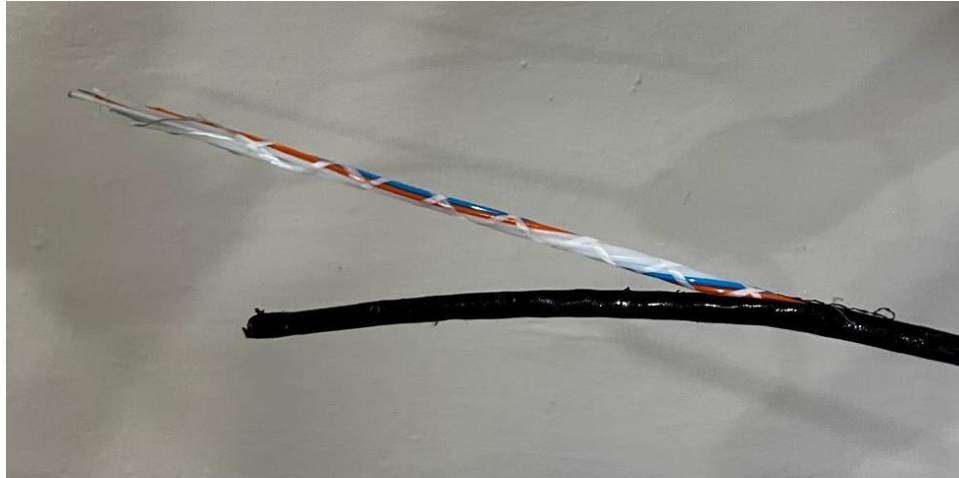
Figura 135. Extracción de cables con hilos de fibra óptica.
