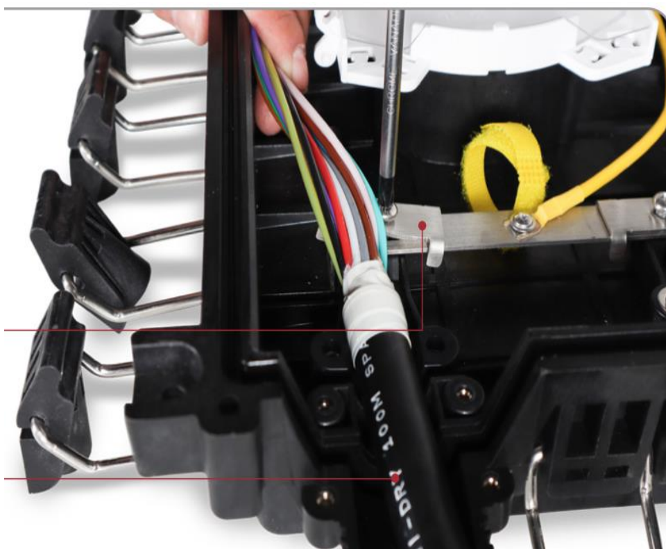
Figura 207. introuccion de cable en mufa. 138
