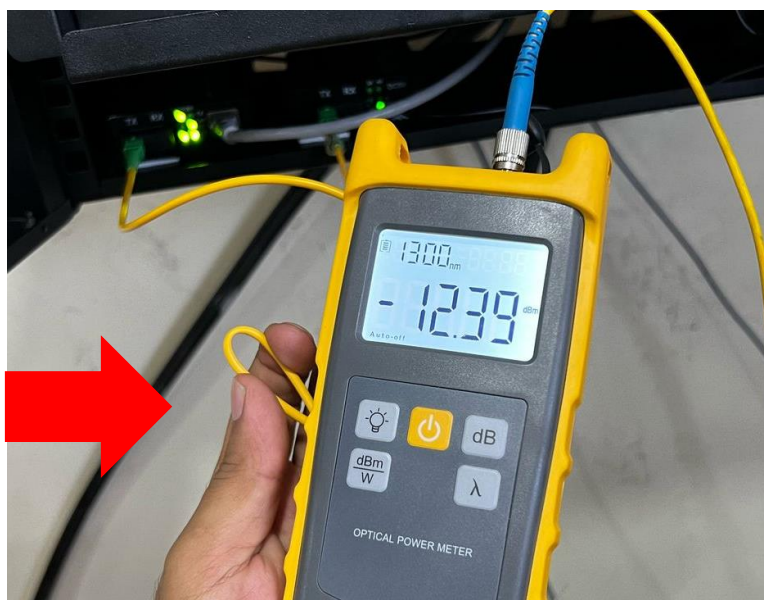
Figura 187. medición casi fuera de rango por atenuación por doblez en fibra.
