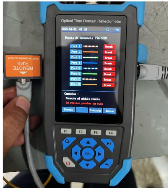
Figura 183. Medición de cable RJ45
