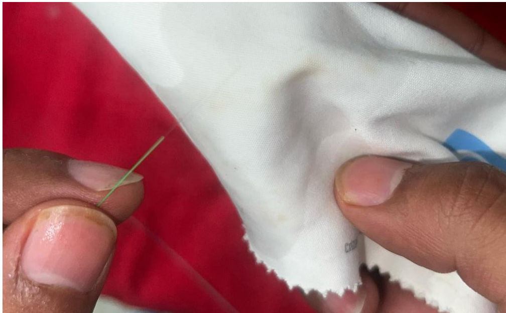
Figura 140. limpieza de núcleo de fibra óptica con alcohol isopropílico.
