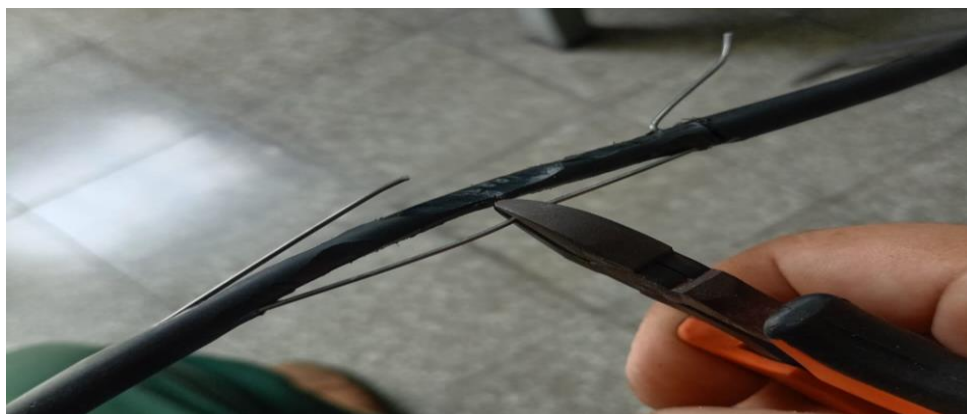
Figura 194. corte de alambres en cable de fibra óptica.
