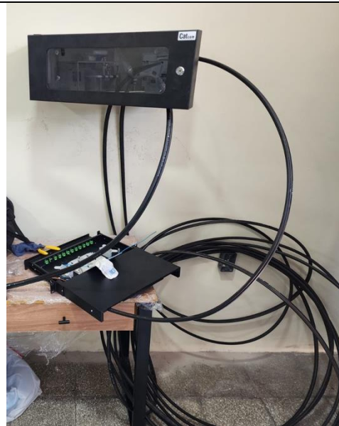
Introducción de cable de fibra óptica en ODF
