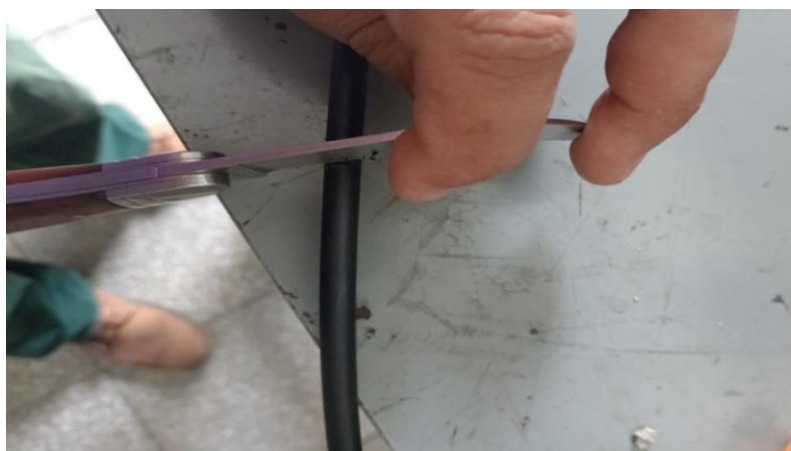
Figura 191. Primer corte en fibra.
