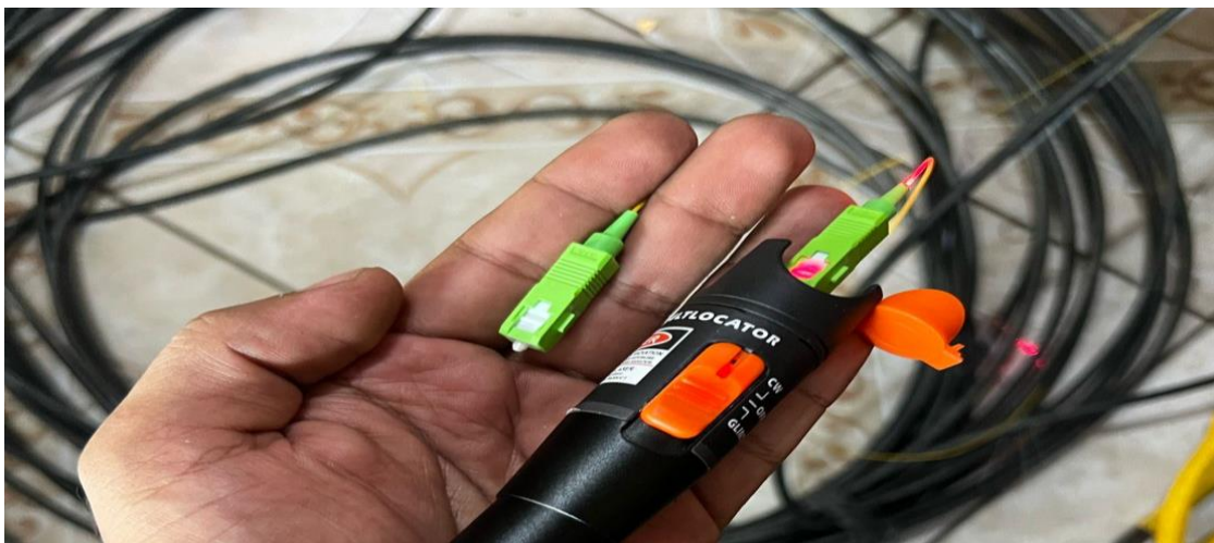
Figura 170. prueba con VFL Haz de luz interrumpido.
