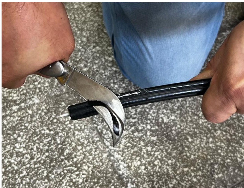
Figura 130. pelado de cable de fibra óptica.
