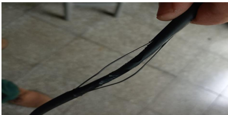
Figura 193. separación de alambres de cable de fibra óptica.
