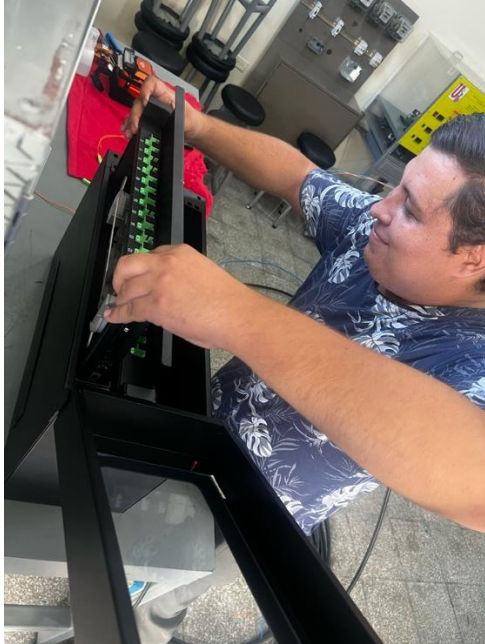
Instalación de ODFs en el Gabinete
