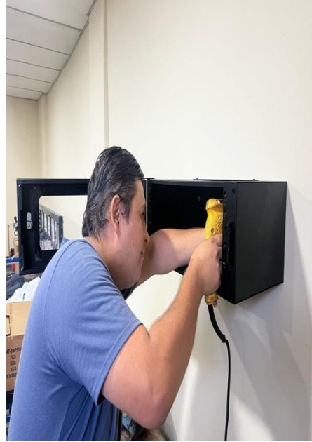
Instalación de gabinete en la pared.
