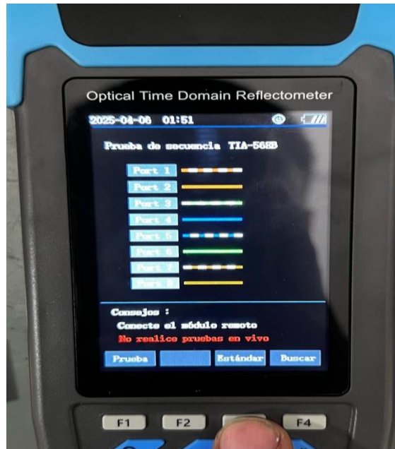
Figura 181. Comprobación del armado de cable RJ45
