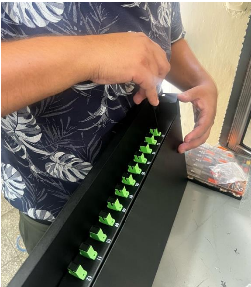
Instalación de acopladores en ODF
