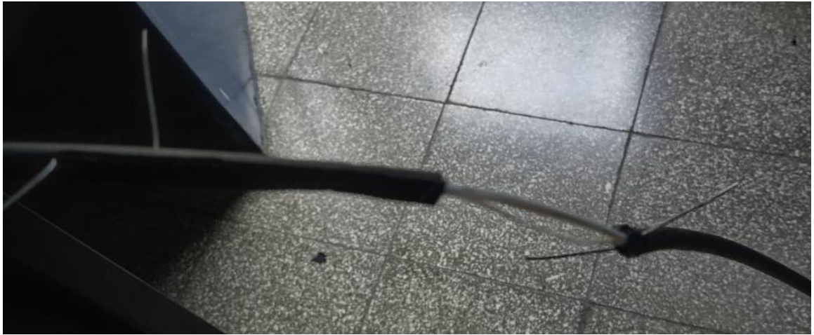
Figura 195. retiro de revestimiento de cable de fibra óptica.
