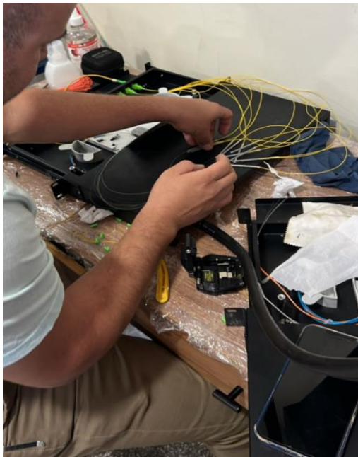
Armado de preparación de ODF con fibra y pigtails ya fusionados.
