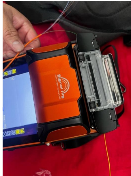
Fusión de fibra óptica con pigtails para su armado en ODF
