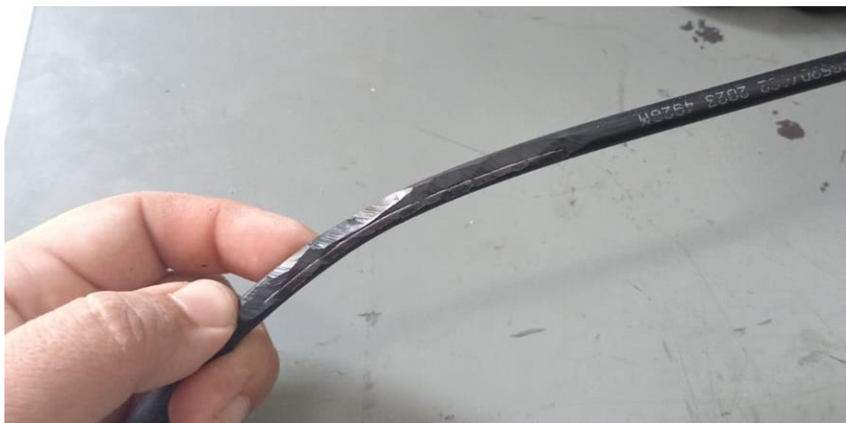
Figura 192. pelado de cable de fibra óptica
