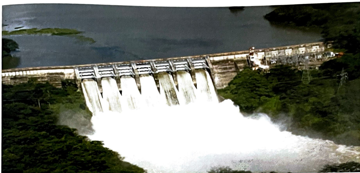
Imagen 26: Central Hidroeléctrica 5 de Noviembre.
