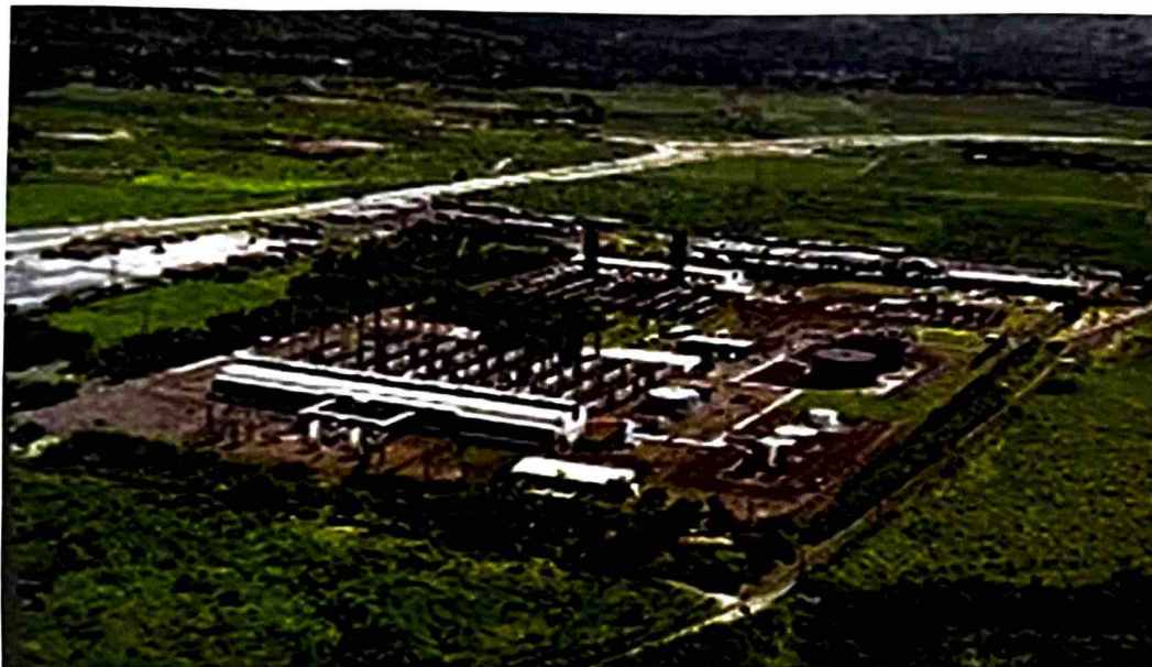
Imagen 31: Central Termoeléctrica Nejapa.
