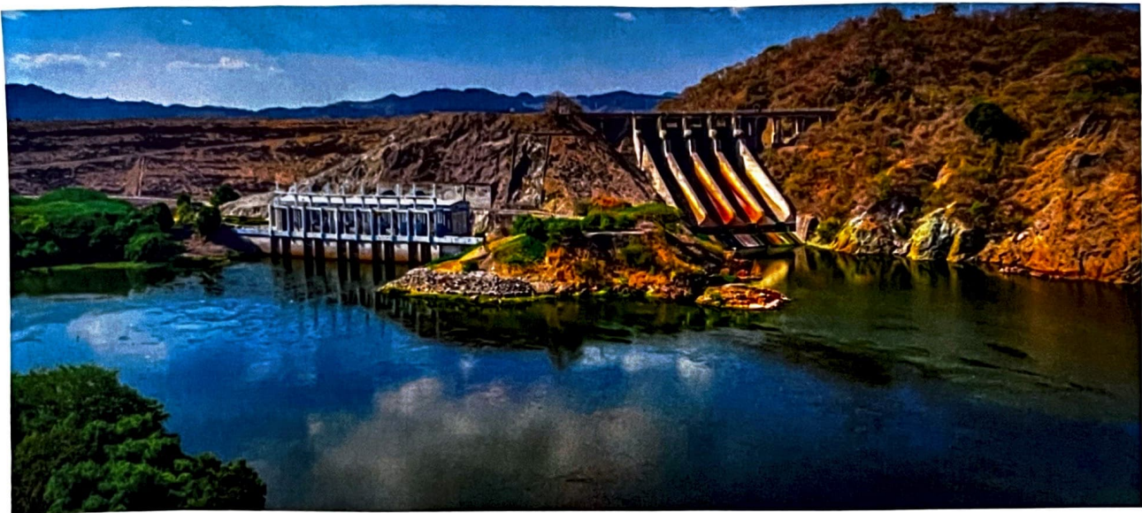
Imagen 25: Central Hidroeléctrica Cerrón Grande.
