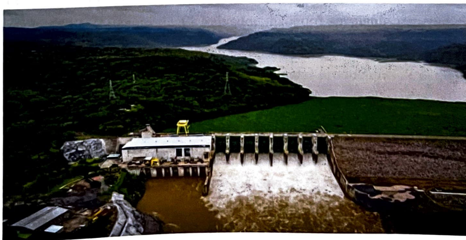
Imagen 27: Central Hidroeléctrica 15 de Septiembre.
