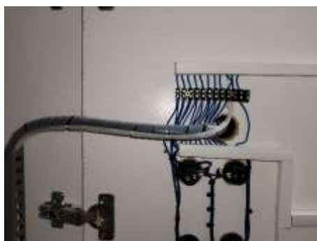
Ilustración 82 Canaleta utilizada para organizar el cable
