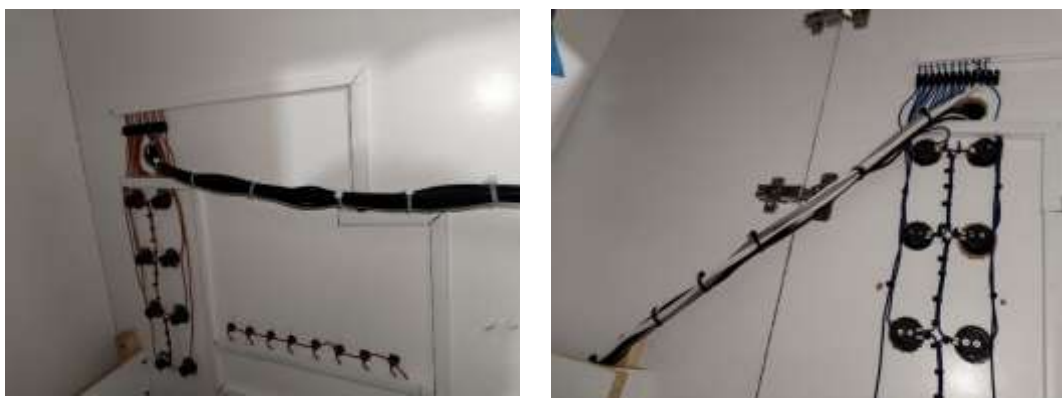
Ilustración 80 Conexión interna del módulo de los pilotos
