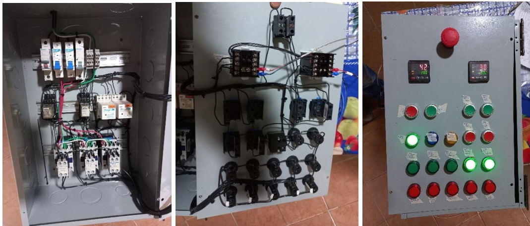
Figura 4.6 Instalación y pruebas de tablero de control (Fuente: Elaboración propia)
