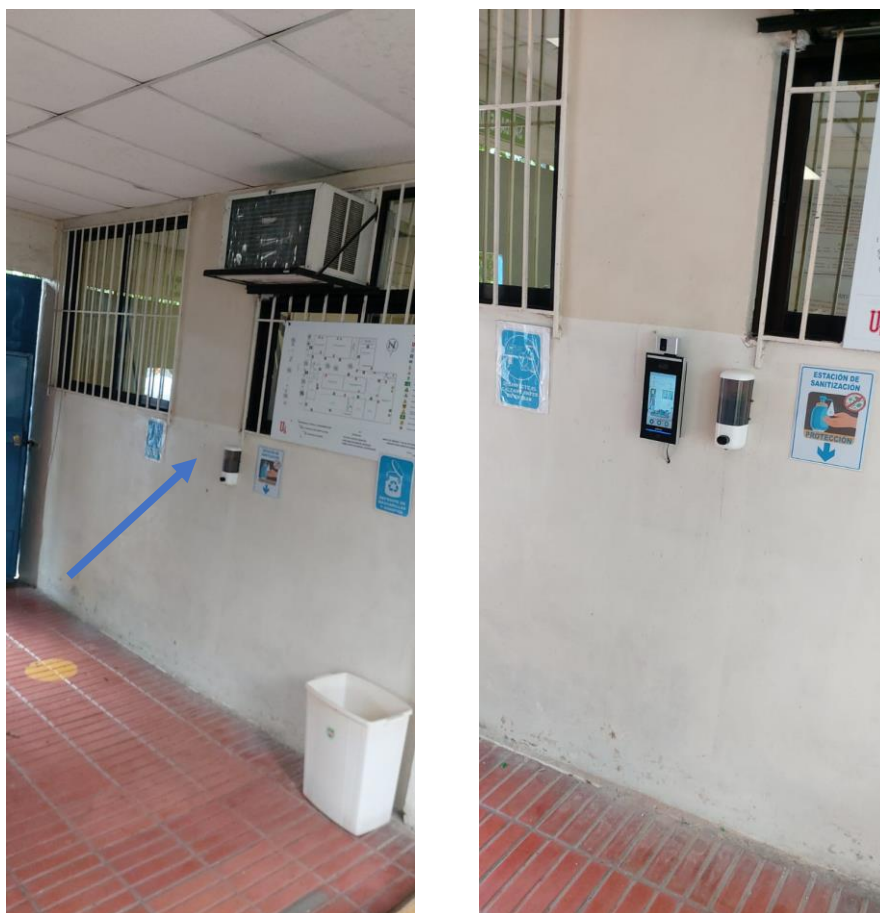
Figura 93 Ubicación de instalación en el ingreso de Laboratorio Especializado
