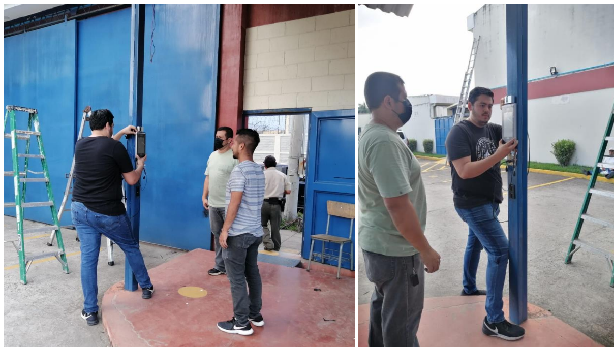
Figura 90 Pruebas iniciales de ubicación del control de acceso
