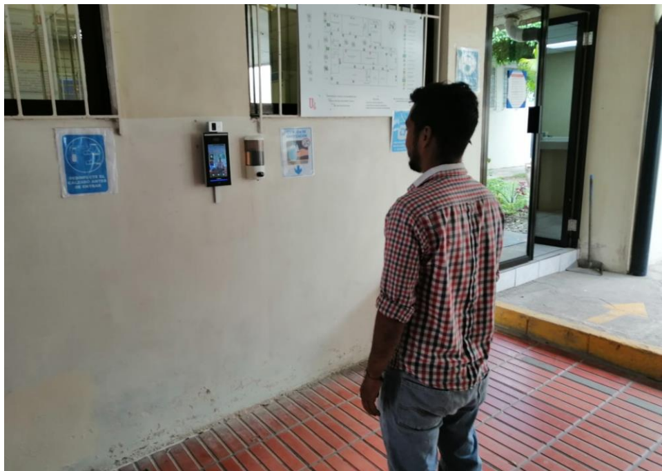
Ilustración 2: Pruebas de funcionamiento del control de acceso.
