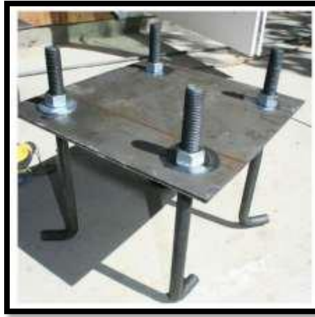
Imagen 8: Placa base (Fuente: diseño Sismorresistente de Construcciones de Acero-Sta Ed | PDF | Acero | Rigidez )
