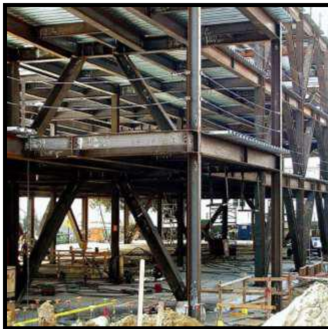
: Marcos excéntricamente arriostrados (fuente: diseño Sismorresistente de Construcciones de Acero-5ta Ed | PDF | Acero | Rigidez ).
